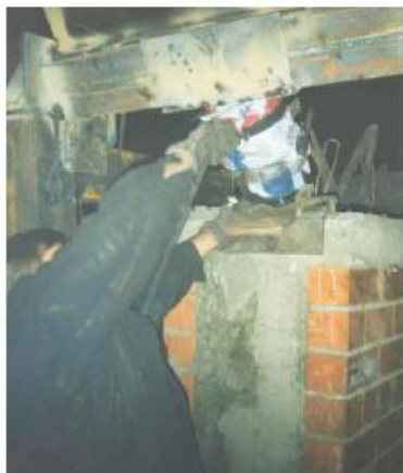
Рисунок 2.1 – Установка домкрата в рабочее положение
